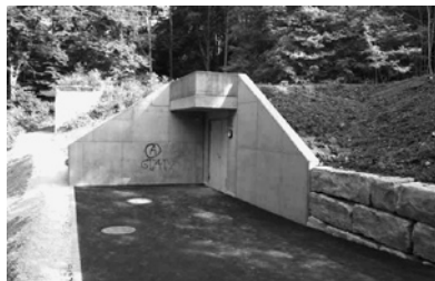
Das neue Reservoir
