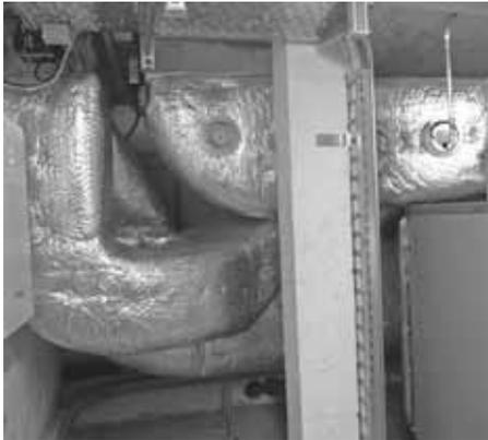
des Meteorwassers und Wärmerückgewinnung, sowohl der Lüftung als auch der Abwärme der Kühlzellen. Auf diese Weise kann die benötigte Energie für Heizung und Warmwasseraufbereitung auf ein Minimum reduziert werden. Die Anlagen für die Heiz- und Lüftungstechnik haben im alten Untergeschoss Platz gefunden. Man sieht vor allem grosse und super isolierte Rohre. Das Abwasser wird in einer „Mini-Kläranlage“ aufbereitet und fliesst dann in den Bach.
