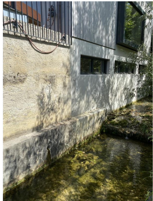
14: Einleitung von Regenabwasser des Gebäudes Mühleweg 41a (SAA, Eigentum privat). Blick entgegen Fließrichtung von linksseitigem Ufer.
