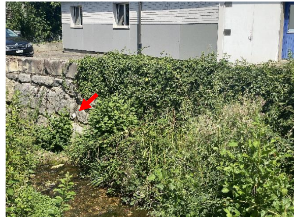
26: Einleitung von Regenabwasser vom Dach des Gebäudes Talstrasse 38. Blick in Fliessrichtung von Brücke auf rechtsseitiges Ufer.
