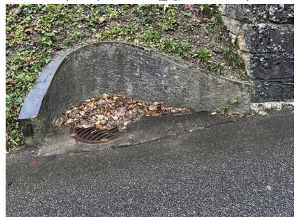
Diverse Einläufe von Strassenabwasser der Talstrasse. Beispielbild eines Einlaufschachtes am Strassenrand (Begehung: 27.11.2023, Natalie Schollmeyer). Einleitstellen am Talbächli nicht auffindbar.
