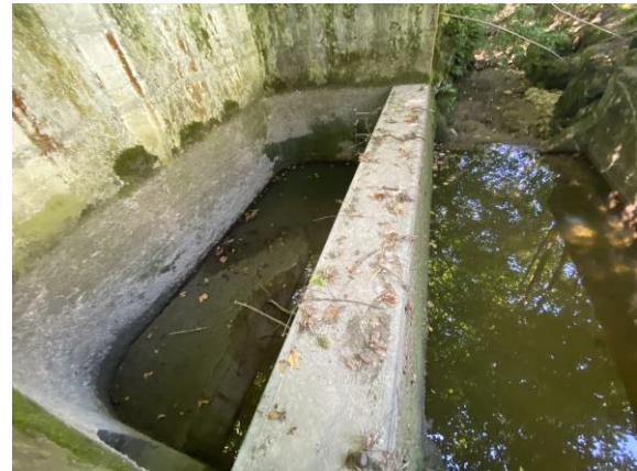
12: Einleitung der Sauberwasserleitung, welche das Wasser des Chälengrabens sowie Strassenabwasser der Mariasteinstrasse (vorrangig ausserhalb Bauzone) fasst. Blick in Fliessrichtung von linksseitigem Ufer (Überlaufschwelle).
